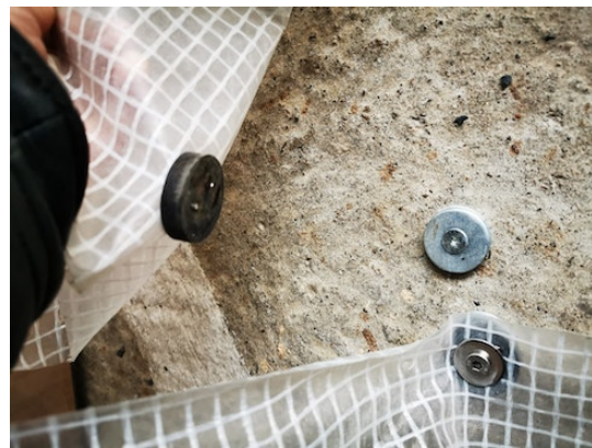
En el suelo y la entrada he utilizado 3 arandelas galvanizadas de 3 mm de grosor (orificio: Ø 11,5 mm) como pieza contraria para los imanes. Desafortunadamente, el catálogo de supermagnete.es todavía no incluye unas arandelas de acero inoxidable tan grandes ;).
