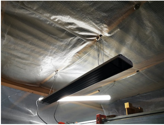
Sujeción al techo de la calefacción de infrarrojos relativamente pesada: 4 OTN-40 - Imanes en recipiente con hembra ( www.supermagnete.es/OTN-40 )
