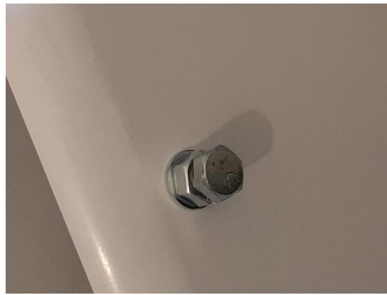
La vis sert de poignée pratique pour la trappe de visite.
